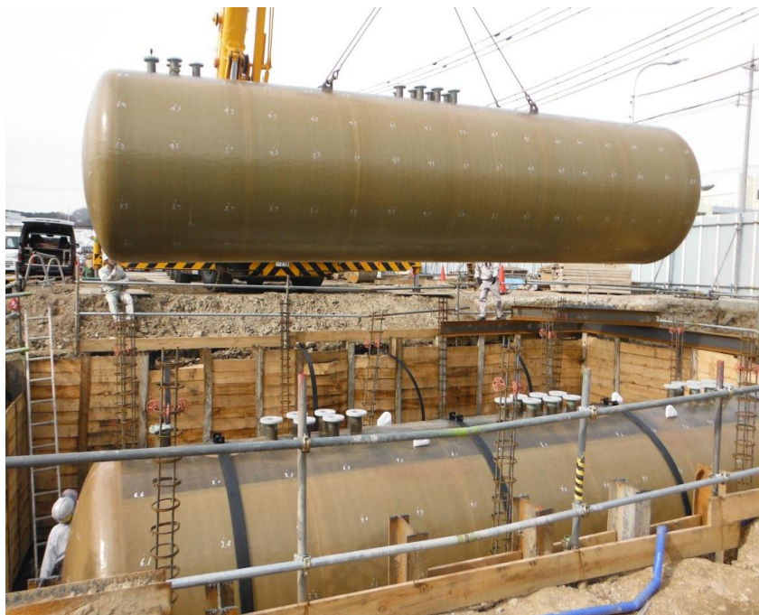
給油取扱所に埋設するタンクの検査
