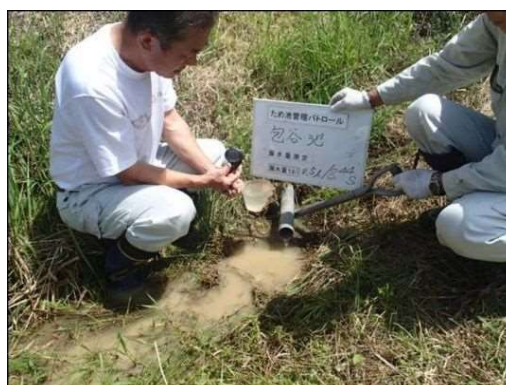
後法 漏水(近景)
