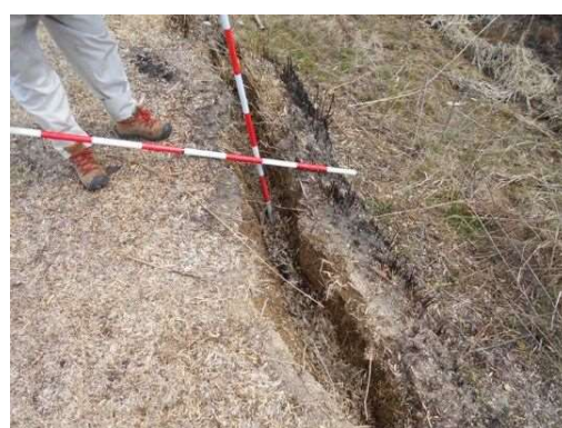
堤頂 ひび割れ
