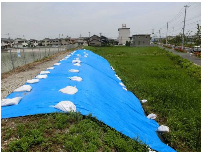
堤体下流法面にブルーシート設置
