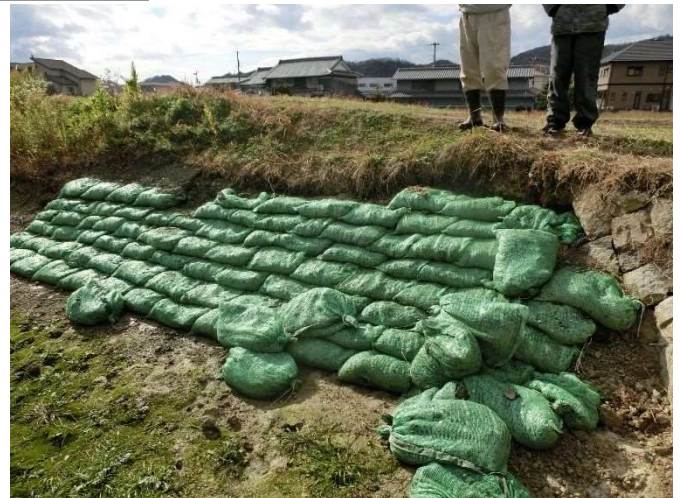
堤体上流法面に土のう設置
