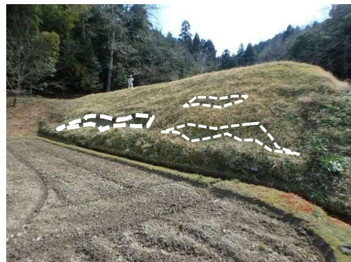
後法 はらみだし及び陥没
