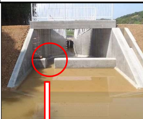
【南あわじ市 洪水吐越流堰の切欠き】
