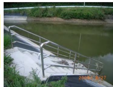
取水口階段・手摺設置状況
