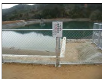
警告看板の設置
