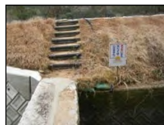
警告看板の設置
