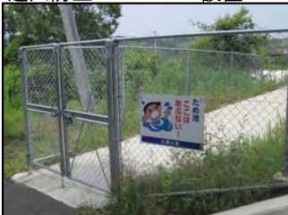
進入防止フェンスの設置
