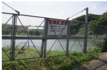
転落防止柵・警告看板の設置
