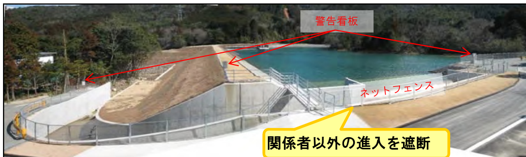
転落防止柵の設置
