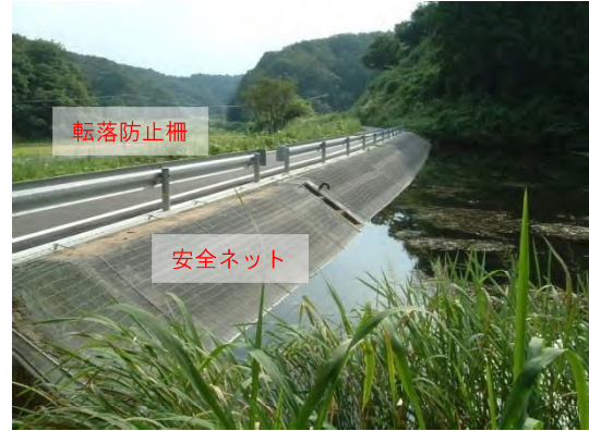
堤体法面に設置した安全ネット
