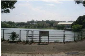
転落防止柵・警告看板の設置
