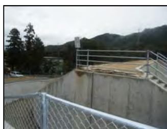
警告看板の設置
