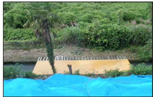
水路への仮蓋の設置
