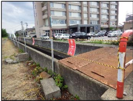
応急ロープの設置
