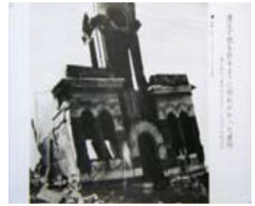
爆圧で倒れかかった建物
