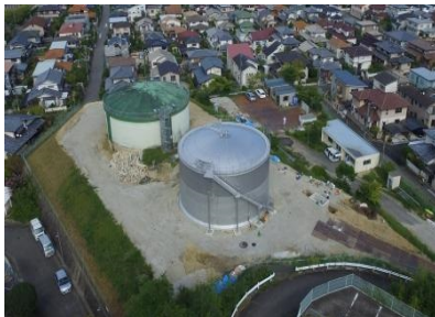
清和台低区配水池
