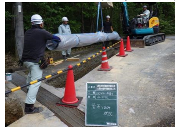
老朽化した配水管の改良工事
