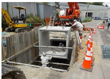
雨水管きょ築造工事
