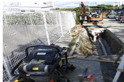
汚水管きょ築造工事
