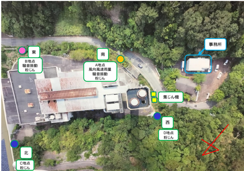
連続粉じんモニタリング設置状況
