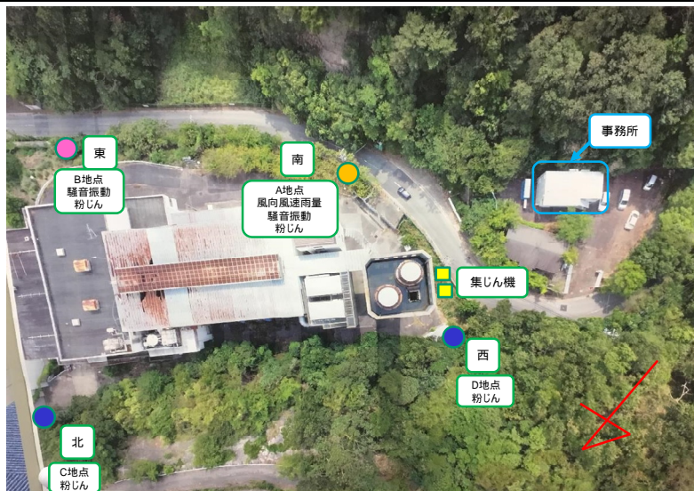
連続粉じんモニタリング設置状況
