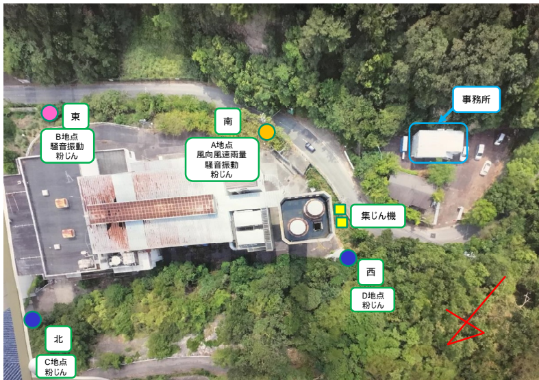
連続粉じんモニタリング設置状況
