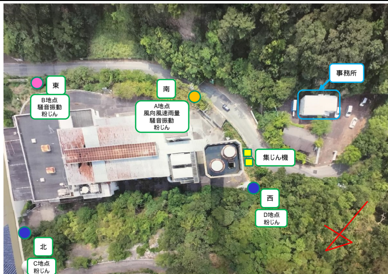
連続粉じんモニタリング設置状況
