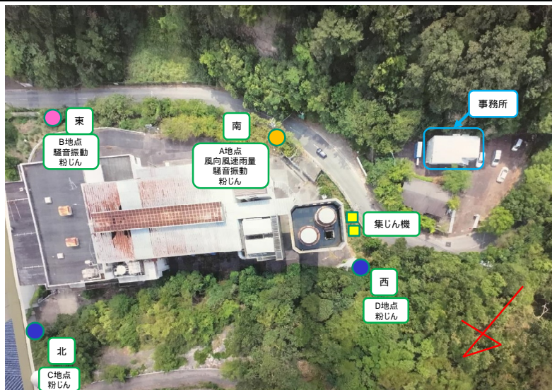
連続粉じんモニタリング設置状況
