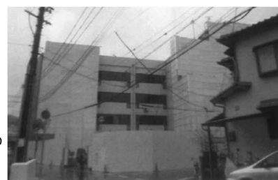
総合体育館側からの 工事の様子
