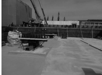
基礎工事施工中
