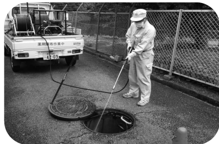
マンホールの薬剤散布の様子
