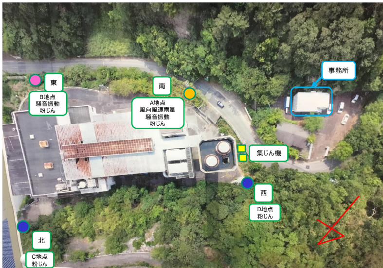
連続粉じんモニタリング設置状況
