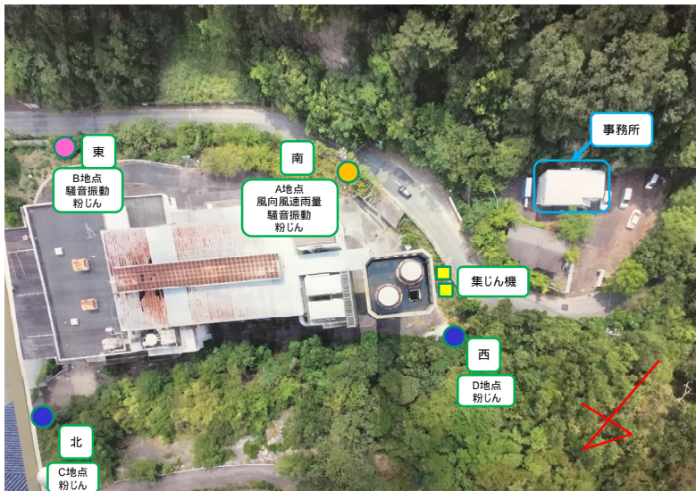
連続粉じんモニタリング設置状況
