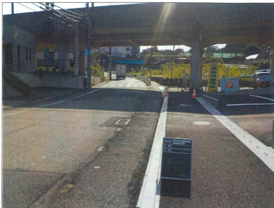
着手前及び完成写真 着工前 No. 13R
