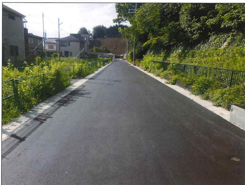
写真区分:着手前及び完成写真 工種:完了
