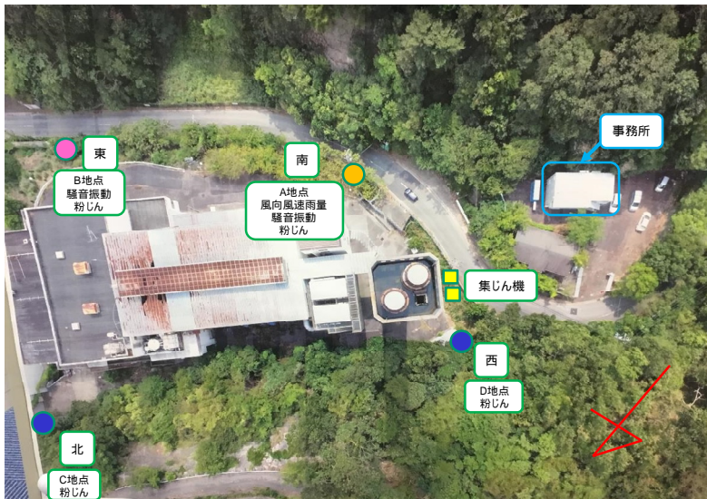
連続粉じんモニタリング設置状況
