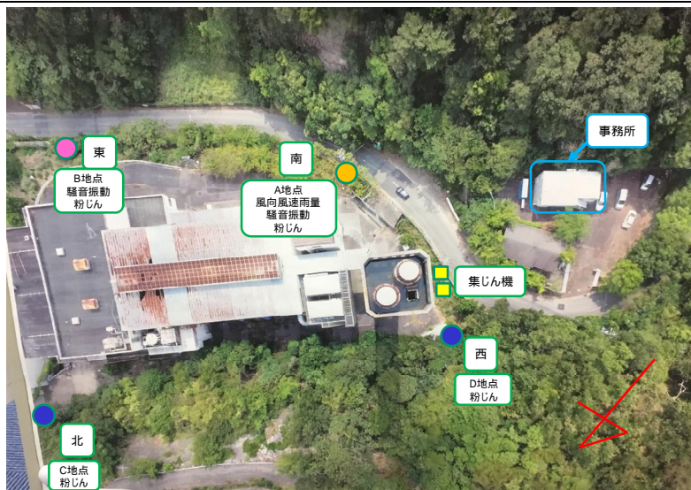
連続粉じんモニタリング設置状況
