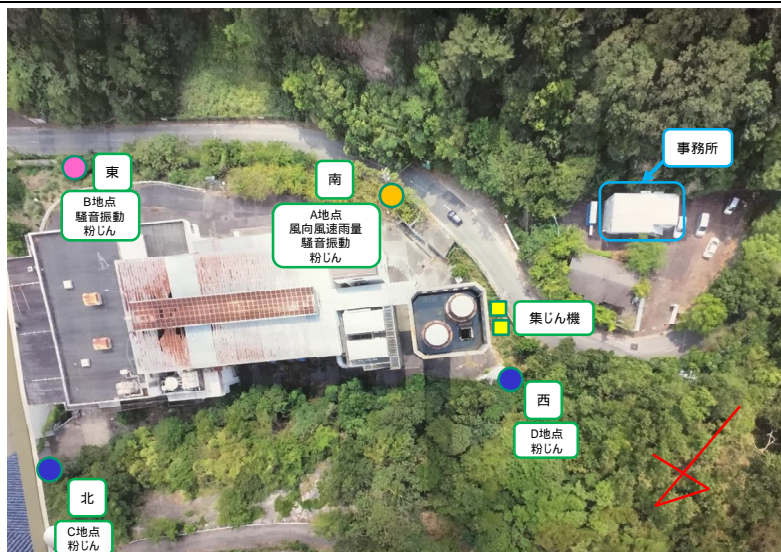
連続粉じんモニタリング設置状況
