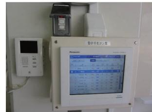
職員室に本事業で設置した新設機器及び事業対象外の既設機器の状態監視、運転制御ができる集中リモコンを設置。
