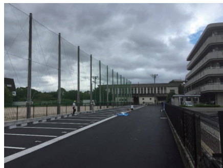
【南側グラウンドの一部を駐車場として整備】
