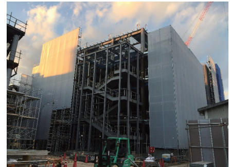
工事中(文化関連施設棟)
