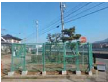
フェンス修理
