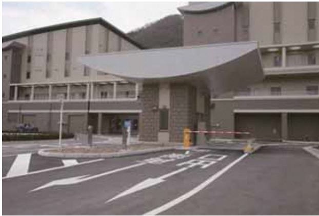
国崎クリーンセンター正面
