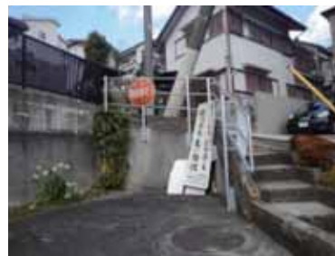
その他の修理(転落防止柵補修)
