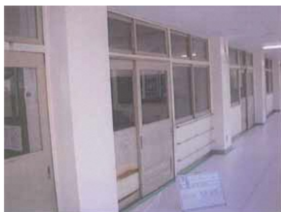
南校舎 2 階 普通教室 改修前
