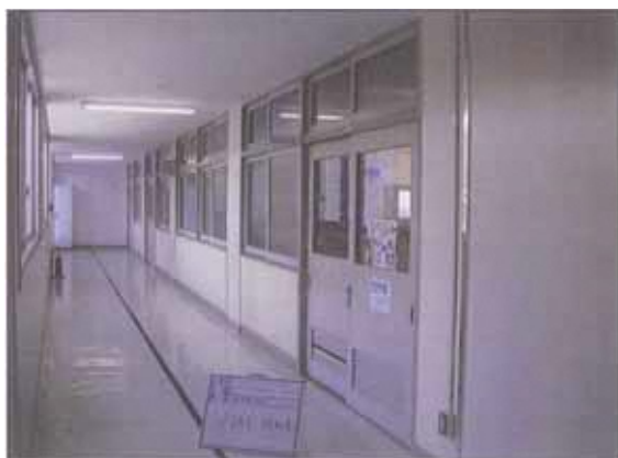
北校舎 2 階 理科室 改修前
