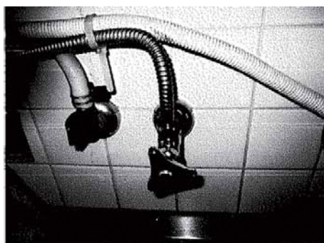
流し台止水栓取替修繕
