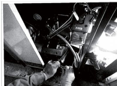
非常用発電機修繕
