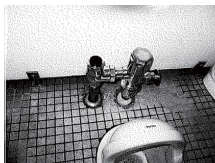
フラッシュバルブ取替修繕
