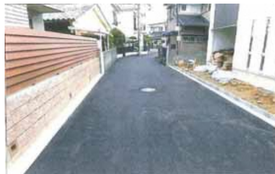
工事完了写真
