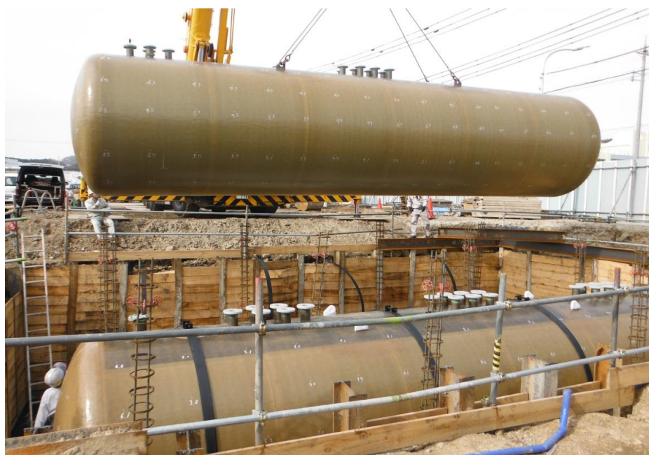
給油取扱所に埋設するタンクの検査
