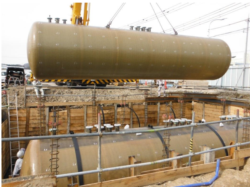
給油取扱所に埋設するタンクの検査
