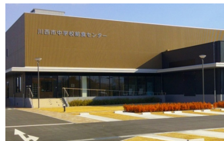
川西市中学校給食センター (久代)
