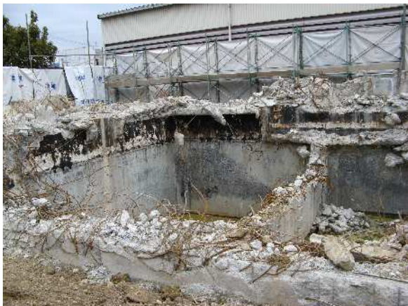
(地下ピット部)
