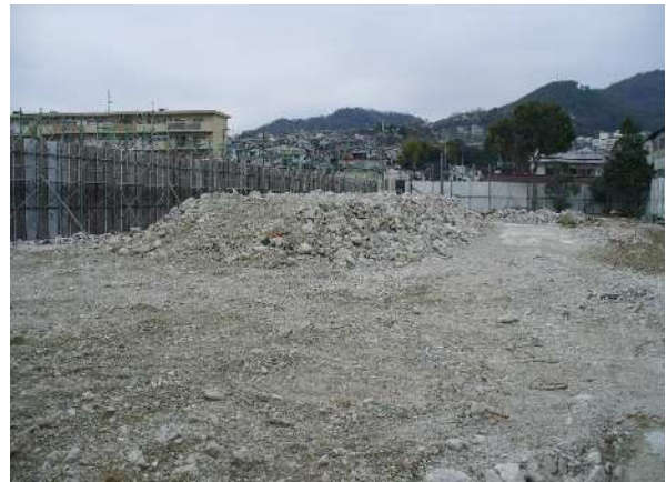
(解体済みで仮覆土状態)
