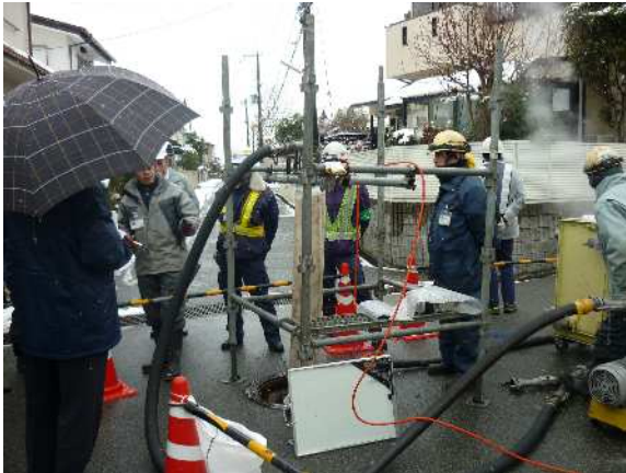
3 ライニング材挿入箇所
