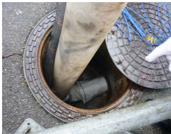
5 マンホール内(拡大)
