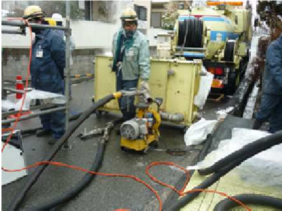
1 給水車(奥側)・温水槽(手前)
