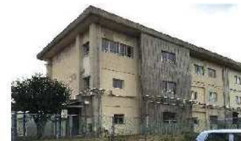
■ 北東側外壁：塗装はく離状況
