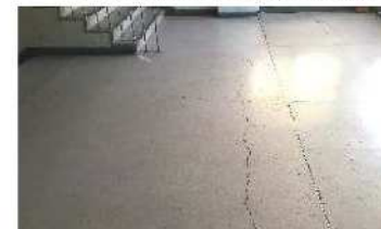
■ 床仕上げひび割れ状況
