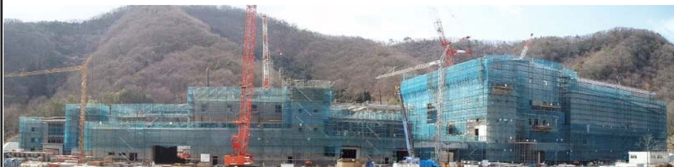
ごみ処理施設建設工事の現況(平成20年3月現在)
