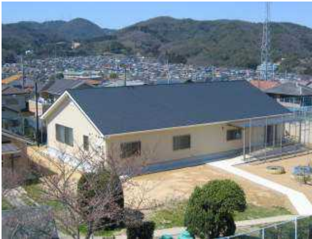
明峰小学校内に整備した育成クラブ室
