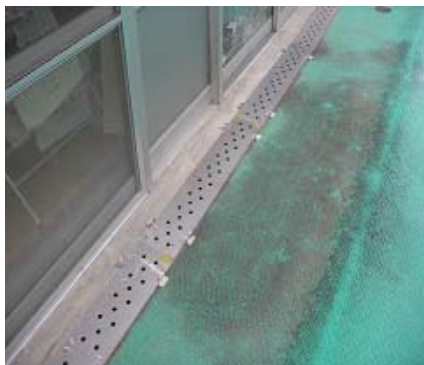
溝蓋修繕(ずれ防止)
