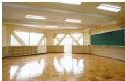
耐震補強と改修して明るくなった普通教室
