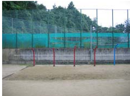
高尺フェンスの取替え
