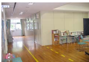
教室間仕切り新設
