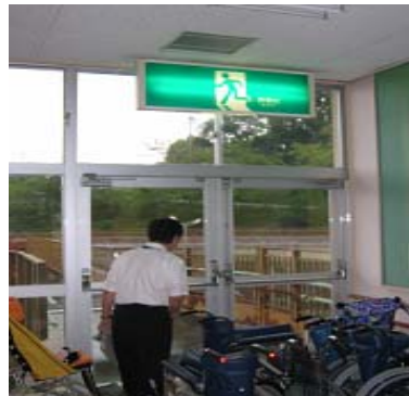
誘導灯取替え修繕
