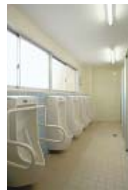
改修後の男子トイレ (自動洗浄装置採用)
