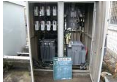
受電設備改修工事(多田中学校)
