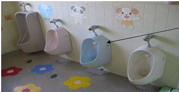
便所の修理(小便器取替え)
