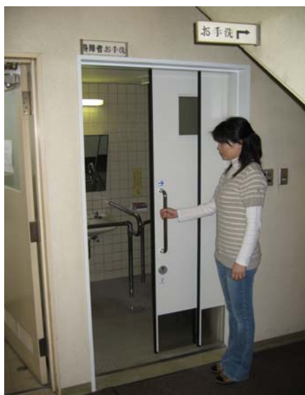
川西南公民館の身体障がい者トイレドアの改修で開閉をスムーズにしました。
