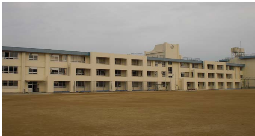
東谷小学校の耐震補強工事外観
