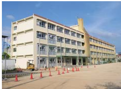
清和台小学校の耐震補強工事外観
