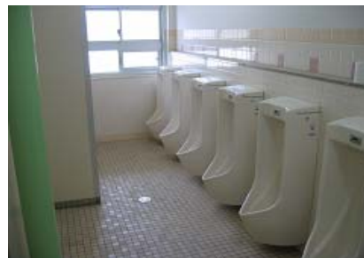
東谷小学校便所改修工事(センサー式)
