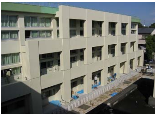
久代小学校の耐震補強工事外観
