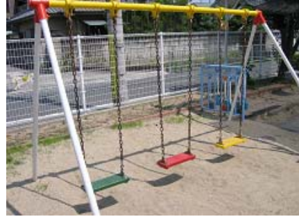
遊具の修理(ブランコ座面の破損等)
