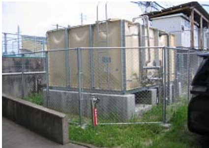
受水槽更新工事
