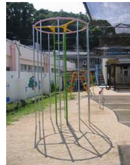
遊具の修理(登り棒腐食)
