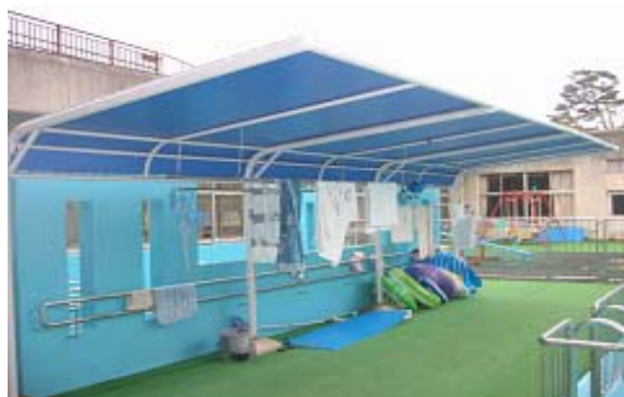
プールサイドテント張替え修繕
