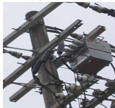
高圧気中開閉器取替え修繕
