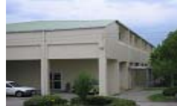
清和台小学校耐震補強工事外観
