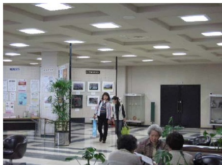
中央公民館アスベスト除去等工事
