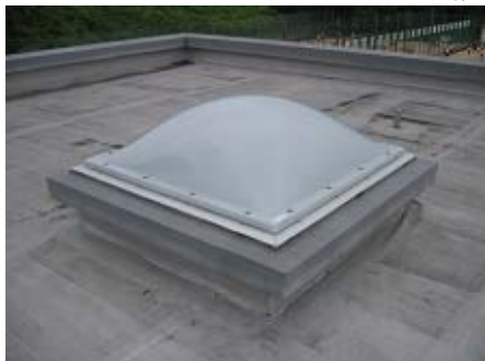
屋上トップライト(明かりとり)の修繕
