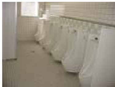
耐震化に併せてセンサー式小便器を設置 (桜が丘小学校)
