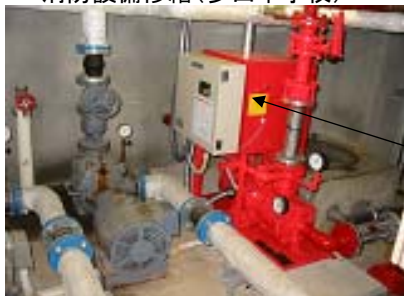
消防設備修繕(多田中学校)
