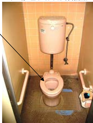
トイレ修理(川西北幼稚園)
