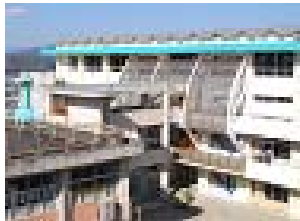
明峰小学校耐震補強工事外観
