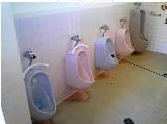
トイレ修理(清和台幼稚園)
