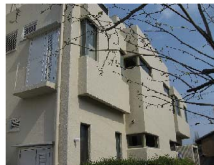
多田公民館外壁・内壁等修繕工事
