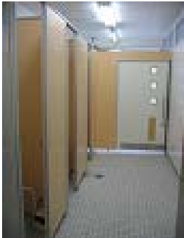
耐震化に併せて実施したトイレ改修(加茂小学校)
