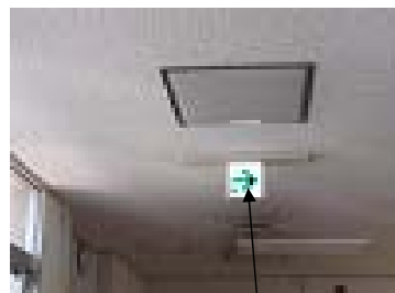
消防設備の修繕(誘導灯の取替え)
