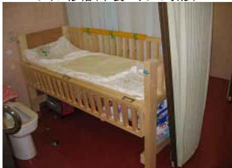
トイレ修繕(木製ベットの改修)
