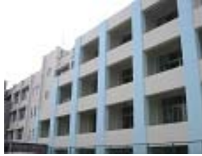
緑台小学校耐震補強工事外観
