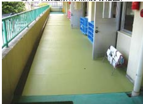
廊下の段差解消(加茂幼稚園)
