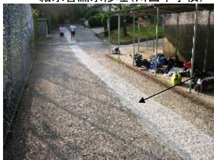
給水管漏水修理(川西中学校)
