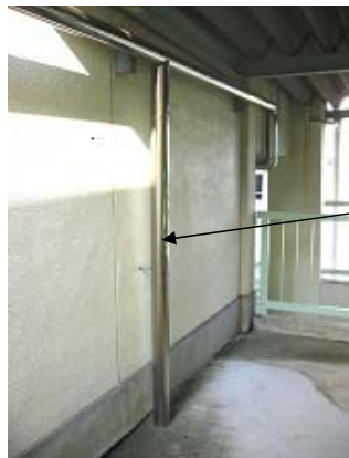
給水管漏水修理(川西中学校)
