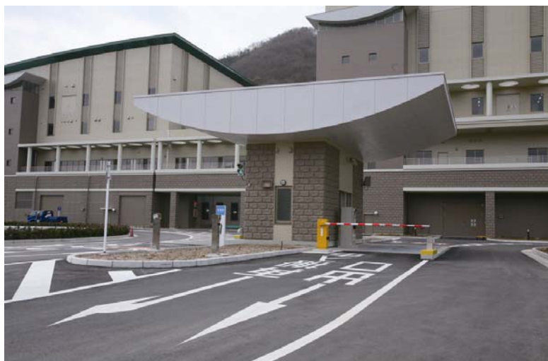
国崎クリーンセンター
