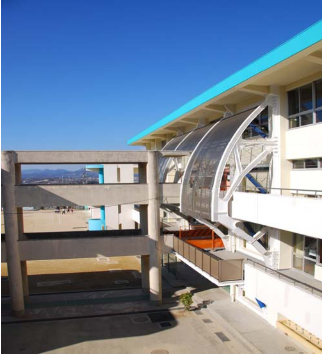
※明峰小学校耐震補強工事完成写真
