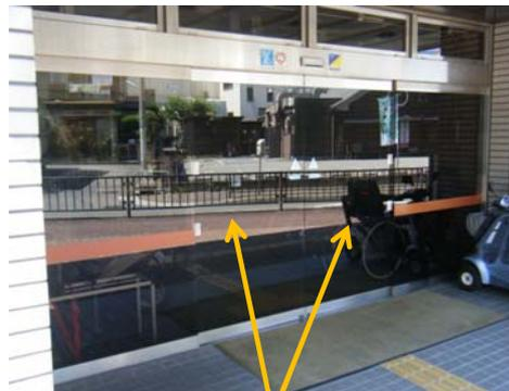
玄関の自動ドアが経年劣化により、安全に開閉する事ができなくなったので、ガラス面の交換を行った。
