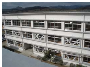
耐震補強工事が完了した 陽明小学校 (北校舎棟)
