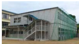
陽明小学校仮設校舎
