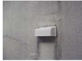
↑ 改修後 (排気フード)
