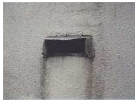
↑ 改修前 (排気フード)
