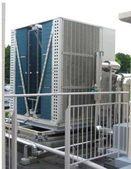
多田公民館 空調機チリングユニット修繕(更新) 多田公民館空調機の老朽化に伴い、更新(入替)を行った。
