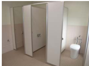
トイレを洋式便器化すると共に、トイレブースもパステルカラーの明るく、優しい色調に統一した。(清和台南小学校西校舎棟)
