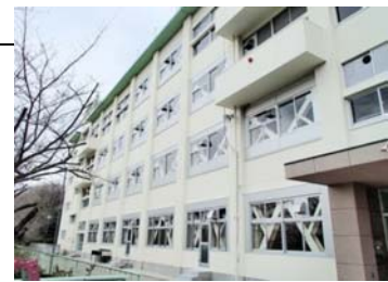
耐震補強工事が完了した 川西中学校 (南校舎棟)
