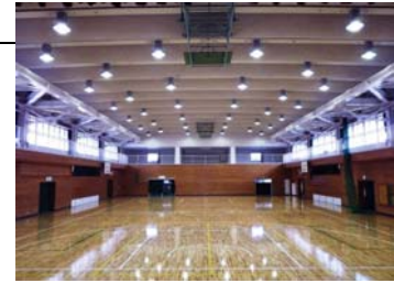
耐震化に併せて体育館の床改修、照明器具の長寿命化を図った。(明峰中学校体育館内部)
