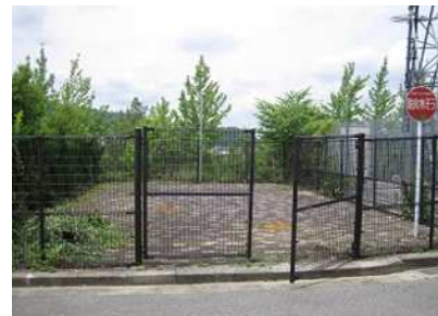
防火水槽の維持管理
