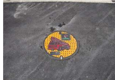
新設消火栓の設置
