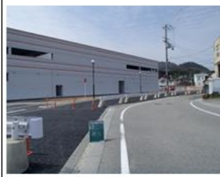
7-1工区現場状況
