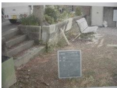
ブロック擁壁修繕 一の鳥居公園 (長尾町)
