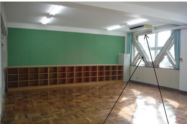
鉄骨プレスにより耐震補強を実施
