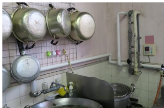
○多田保育所 給湯管漏水修繕
