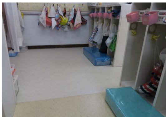
○川西保育所 保育室床修繕
