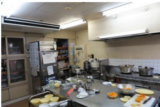
○川西中央保育所 調理室空調機・ガス機器更新
