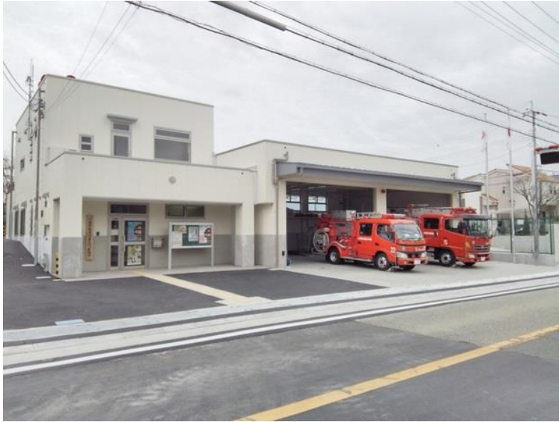
新しくなった、 南消防署久代出張所
