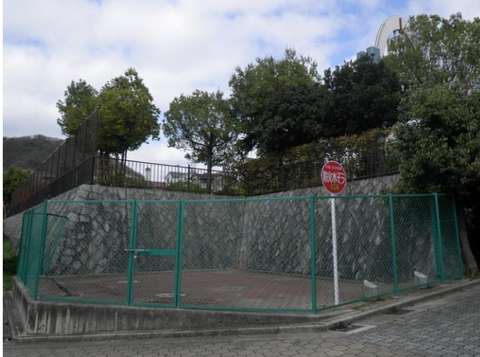
防火水槽修繕箇所
