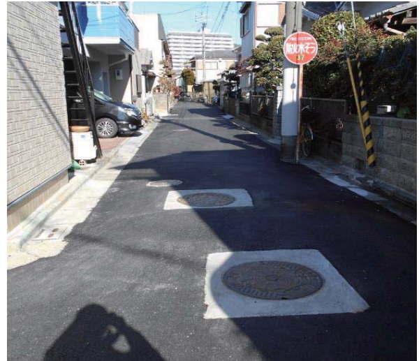
工事完了写真
