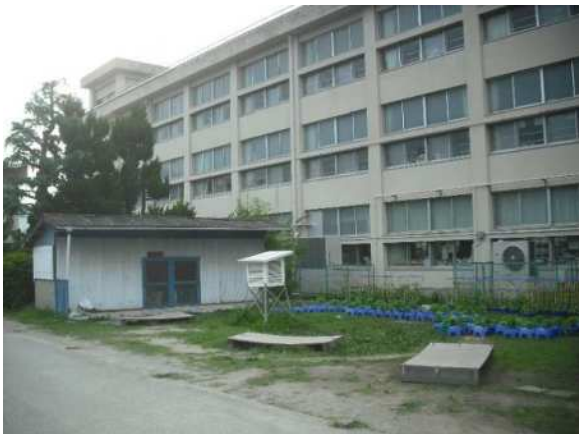
久代小学校の耐震工事施工前
