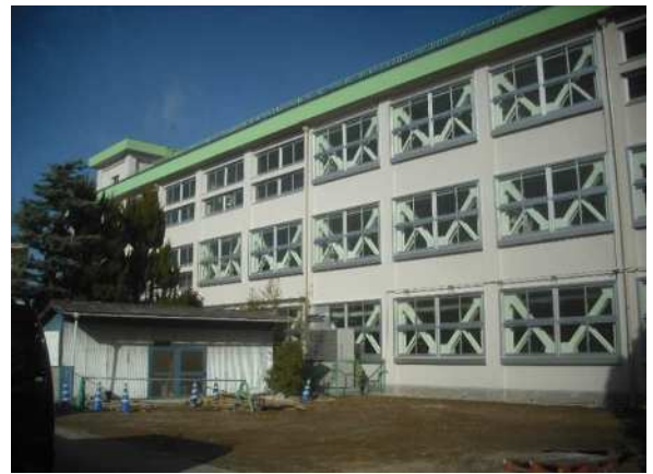
久代小学校の耐震工事施工後
