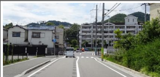
市道1313号 (道路拡幅、歩道設置)
