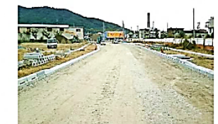
豊川橋山手線 (施工状況)
