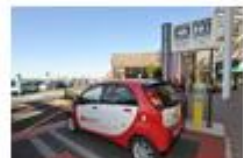
電気自動車 急速充電ステーション
