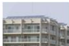
集合住宅屋上の 太陽熱温水パネル
